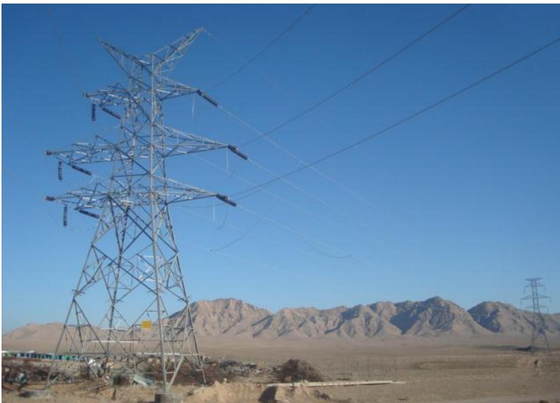
خط انتقال برق ۱۳۲ کیلو ولت دو مداره اختصاصی کارخانه متناسب با ظرفیت کل خط تولید به همراه پست اصلی ورودی کارخانه مشتمل بر بخش های ولتاژ بالا (H.V) ترانسفورماتور ورودی 30MVA و بخش ولتاژ متوسط (MV) از جمله تاسیسات زیربنایی کارخانه است که برای کل خط تولید اجرا گردیده است.
