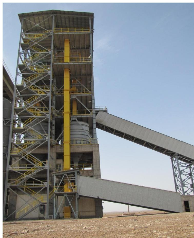
بخش تغذیه آسیاب و سیستم انتقال کلینکر و انتقال گچ منتهی به آن
